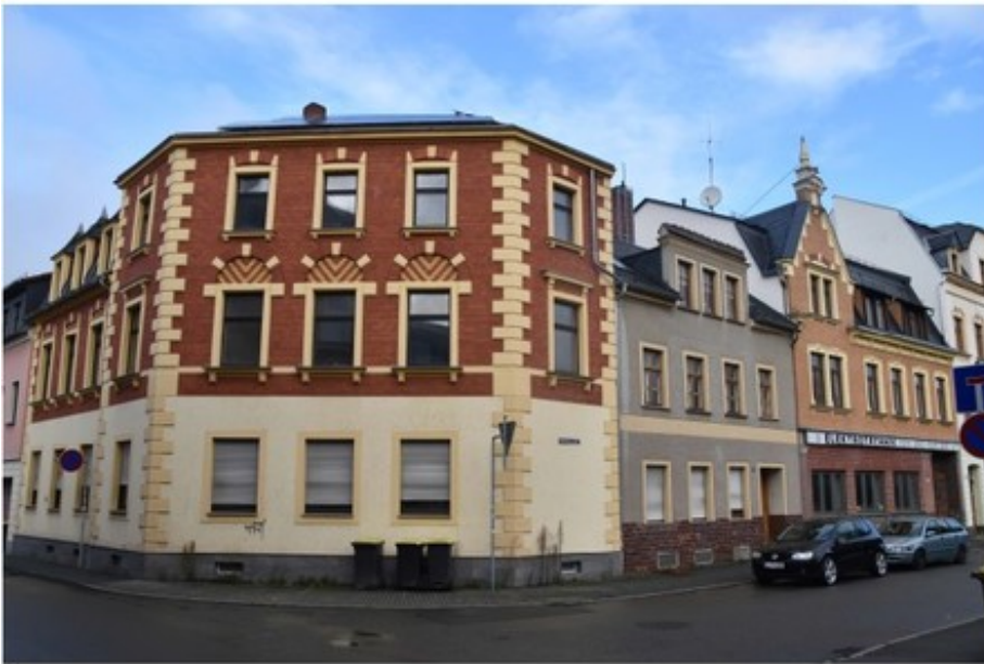
Straßenansicht, von links: Gebäude Ritterstraße 17 a, Gablenzer Straße 1 und Gablenzer Straße 3
