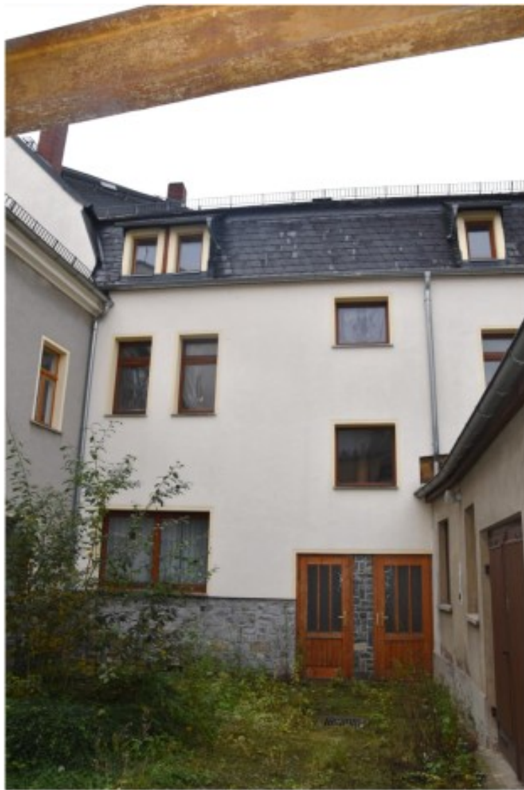
Rückansicht Gebäude Ritterstraße 17 a
