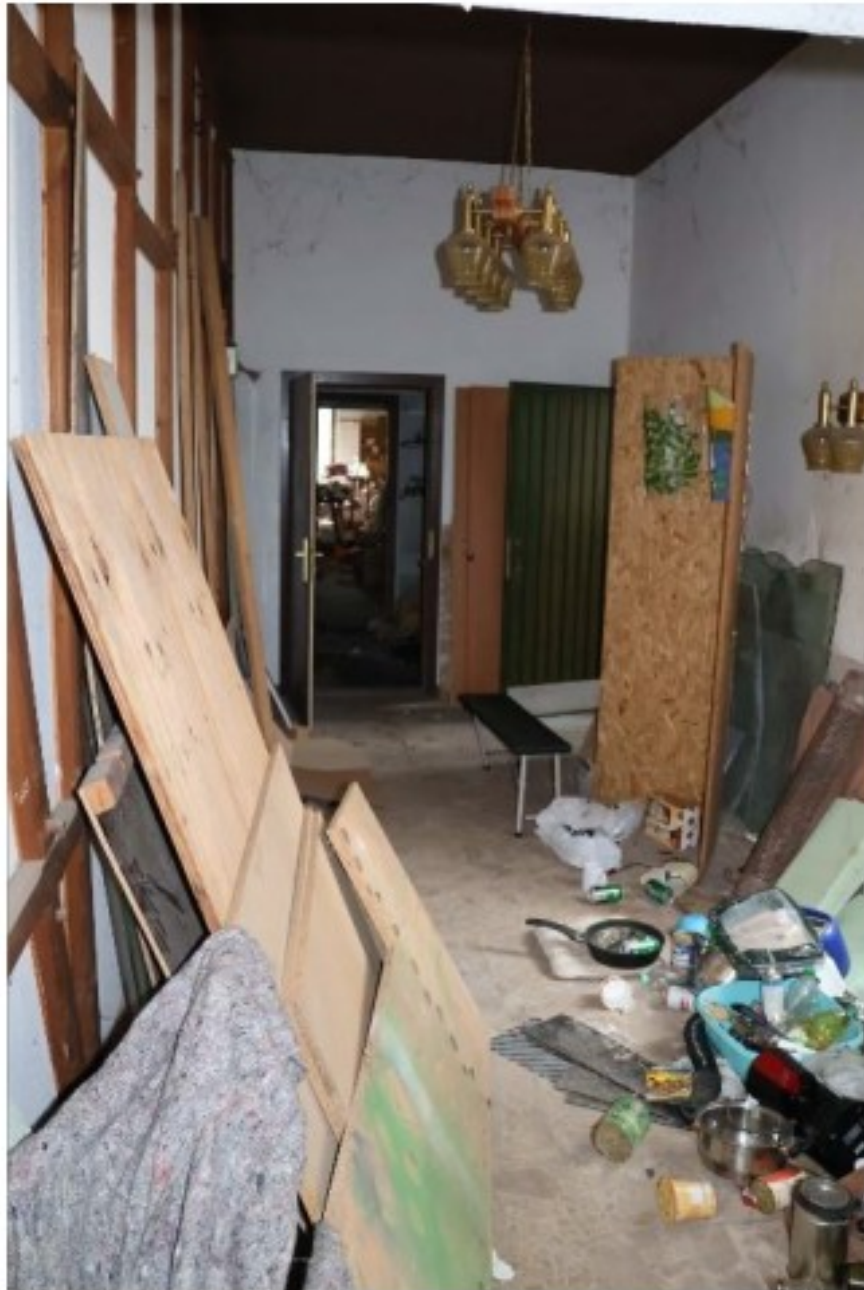
Vorderhaus, EG, Flur/ ehemalige Gasträume
