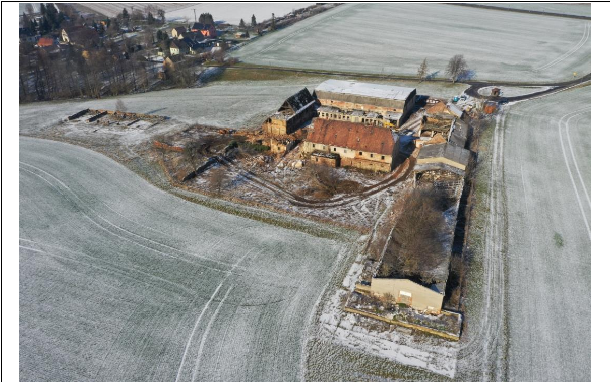
Bild 2: Maßnahmenfläche Anfang Februar 2023
