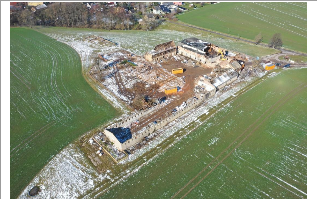
Bild 3: Maßnahmenfläche Ende Februar 2023
